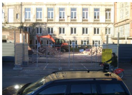
septembre 2015 - début des travaux
