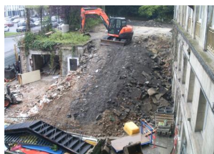
septembre 2015 - début des travaux
