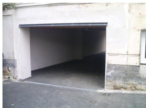
Création d'un passage entre les 2 cours juillet Août 2016
