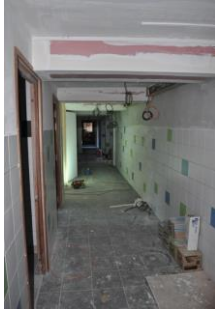
Modification salle de restauration et cuisine en cours
