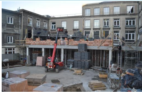
Novembre 2016 en cours nouveau bâtiment, sanitaires + salles de classes sur 3 étages et ascenseur achèvement 2018
