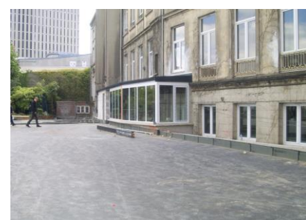
Nouvelle cour arrière avenue du Peuple belge en septembre 2016
