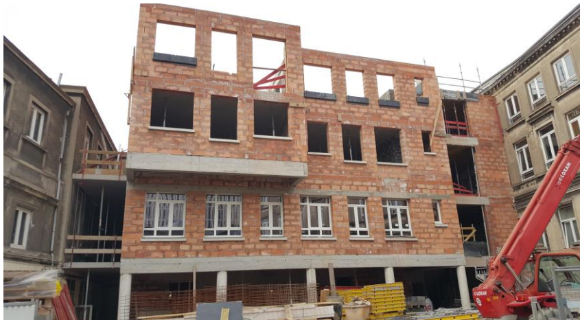
Mars 2017 en cours nouveau bâtiment, sanitaires + salles de classes sur 3 étages et ascenseur achèvement 2018
