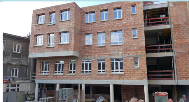
Avril 2017 en cours nouveau bâtiment, sanitaires + salles de classes sur 3 étages et ascenseur achèvement 2018
